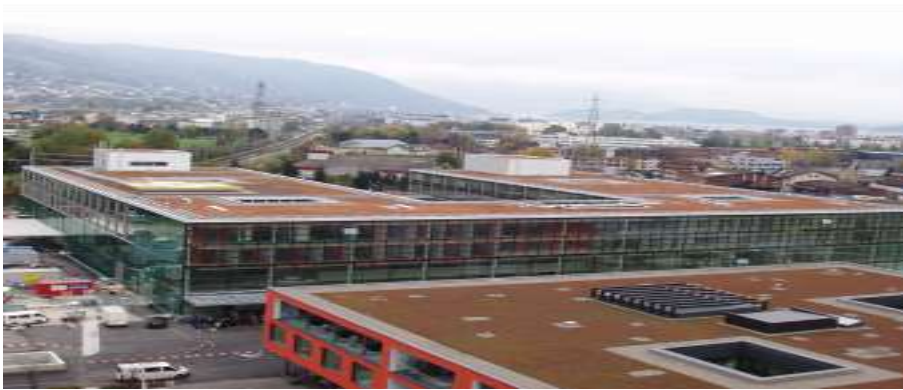
Госпиталь в Цуг, Швейцария
